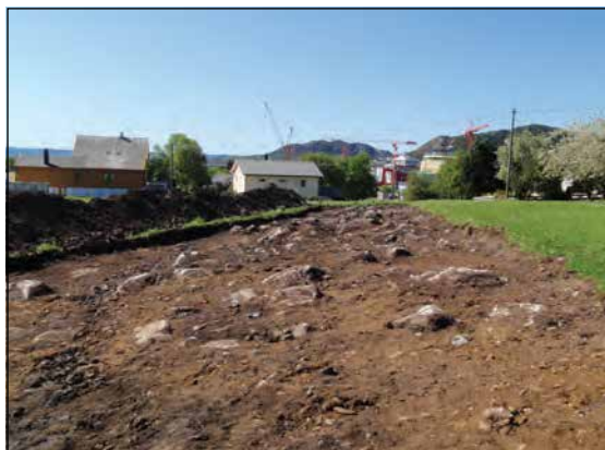
Figur 8. Område 3 etter avdekking, undergrunnen er uoversiktlig dels bestående av steinblokker (foto C. Zinsli. Mot V).
